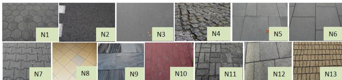
Rys.3. Typy nawierzchni wykorzystanych w badaniach: N1-kostka 6-ciokątna, N2-asfalt na ścieżce rowerowej, N3-asfalt drogowy, N4-kostka granitowa, N5-kostka brukowa 60×60, N6-kostka brukowa 50×50, N7-kostka brukowa „kość”, N8-płytki terakotowe kwadratowe, N9-płytki terakotowe prostokątne, N10-kostka brukowa przystanek tramwajowy, N11-kostka brukowa mozaika, N12-kostka brukowa zjeżdźcie dla osób niepełnosprawnych, N13-kostka brukowa kwadratowa 7×7
